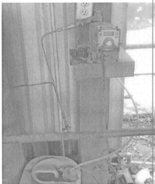
Foto 5. Dosificador de resina para el ablandamiento de aguas de caldera.
